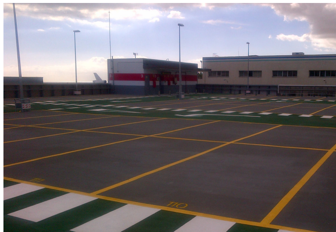
Acabado final de la cubierta parking impermeabilizada con el Sistema MasterSeal Traffic 2201
