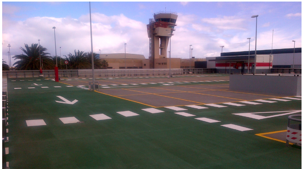
Parte de los 5000 m 2 de cubierta impermeabilizados con el Sistema MasterSeal Traffic 2201
